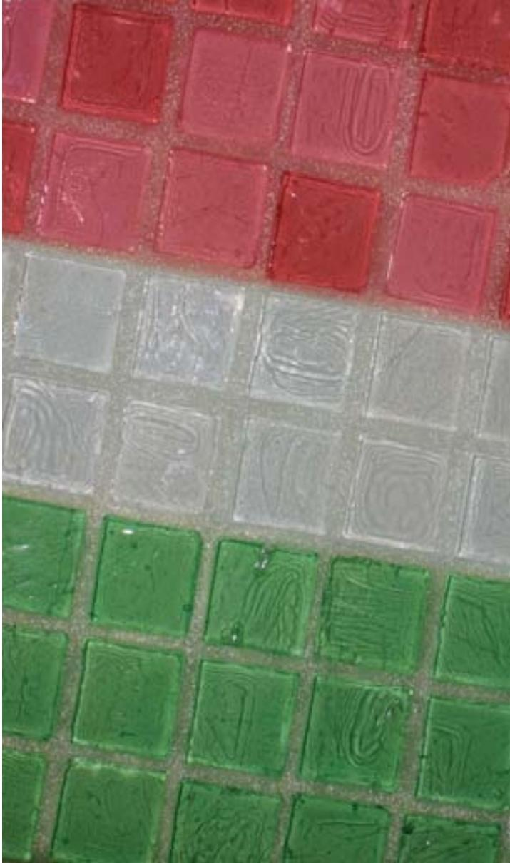
■ Эпоксидная смесь на основе инертного наполнителя, состоящего из стеклянных сфер.
