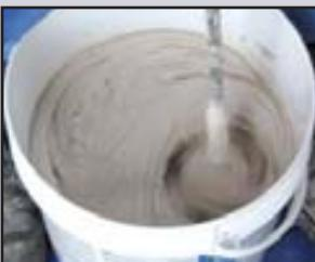
Перемешайте продукт, используя при этом электродрель с насадкой – миксером, до получения однородной массы. Соскребите неперемешанный продукт со стенок и дна ведра, используя мастерок или шпатель, и смешайте его с основной массой **LITOCHROM STARLIKE**.
