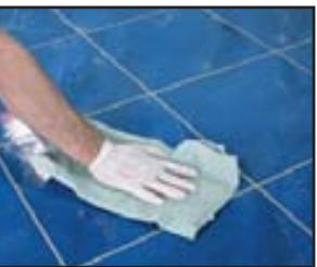
Возможные разводы или остатки эпоксидного состава (налёт в виде прозрачной пленки, типичный для катализируемых составов), можно удалить с поверхности плитки в течение 24 часов с помощью чистящих составов **LITONET** или **LITONET GEL**.
