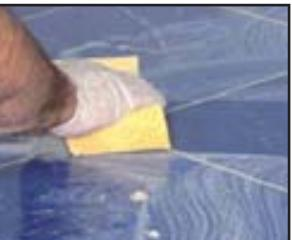
Заполните швы полученным составом, используя специальный шпатель со сменной резиновой насадкой, выполняя движения по диагонали относительно швов.
