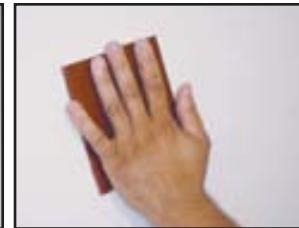
Абсорбирующие основания, типа цементных штукатурок, бетона, гипсокартона или облегченные панели должны обрабатываться грунтовкой **PRIMER C-м.** Ранее существовавшая покраска, включая основание отделочного слоя, поверхностная известковая отделка, цемент или гипс, наложенные тонким слоем, должны быть удалены, а основание должно быть обработано грунтовкой **Primer C-м.**
