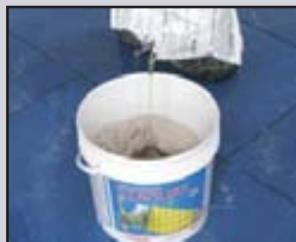
Срежьте уголок пакетика с катализатором, находящегося внутри пластикового ведра, и вылейте содержимое в ёмкость с **LITOCHROM STARLIKE**. Рекомендуем использовать катализатор полностью.
