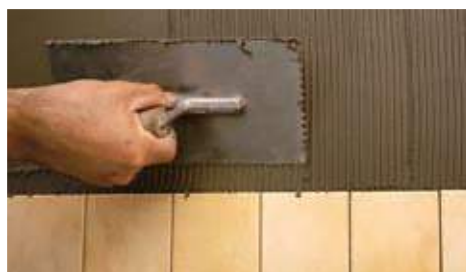
Нанесение LITOKOL K17 зубчатым шпателем
