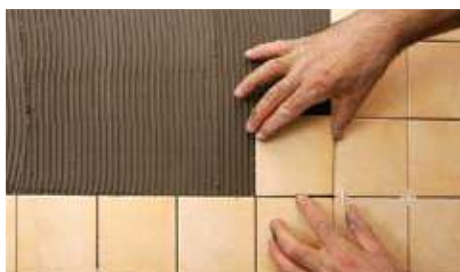
Укладка плиток на пол на клей LITOKOL K17
