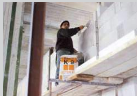
Кладка перегородок из пеноблоков
