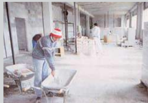
Приготовление раствора ВЕТОНКОЛ К9
