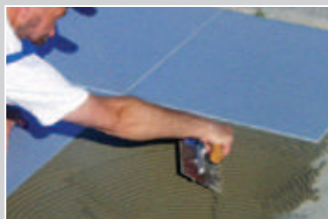
Укладка крупноформатной плитки на клей SUPERFLEX K77
