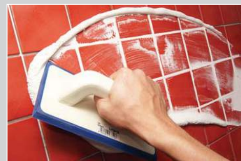
Нанесение LITOSCHROM 1-6 резиновым шпателем
