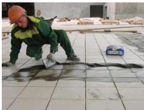
Использование LITOSCHROM 3-15 для затирки швов на полах из керамогранита в гипермаркете «Ашан» (Москва).
